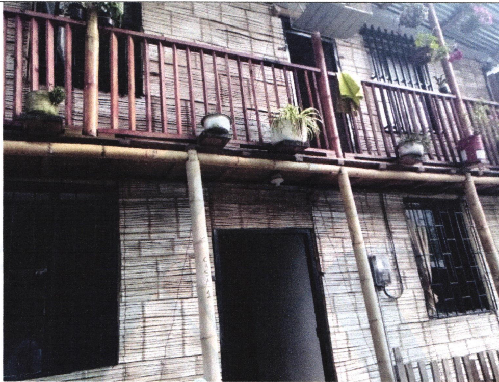
Las casas cuentan con medidores de energía.
